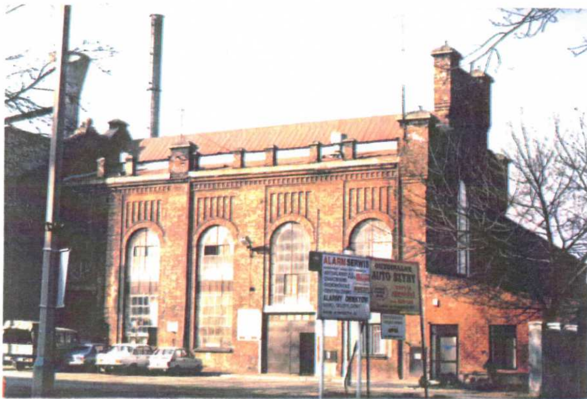
13. BUDYNEK CIEPŁOWNI PRZY UL. TRAUGUTTA - KOPERNIKA
