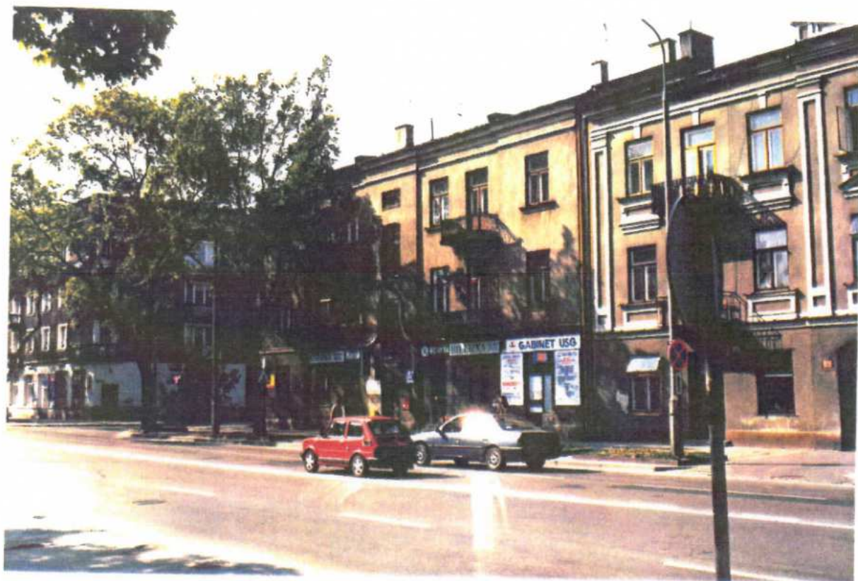
19. BUDYNEK PRZY UL. ŻEROMSKIEGO 87
