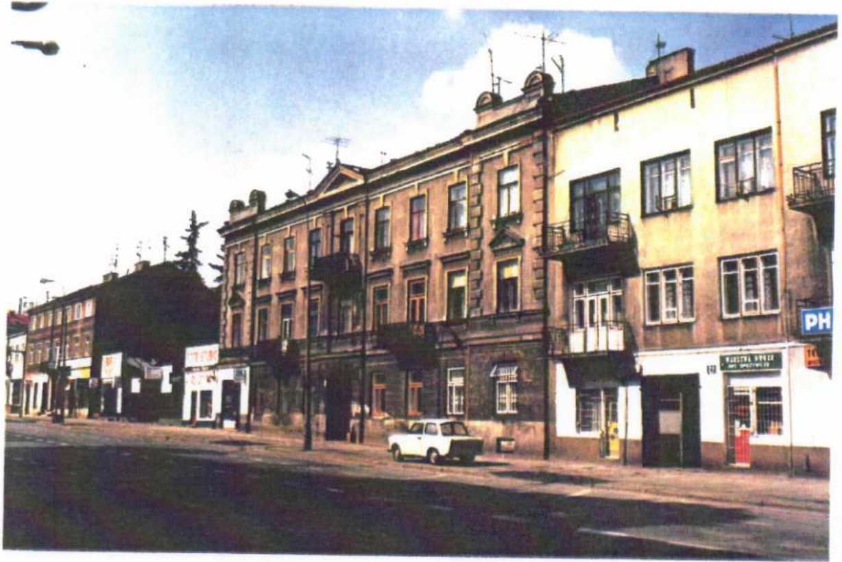
6. BUDYNEK PRZY UL. SŁOWACKIEGO 25
