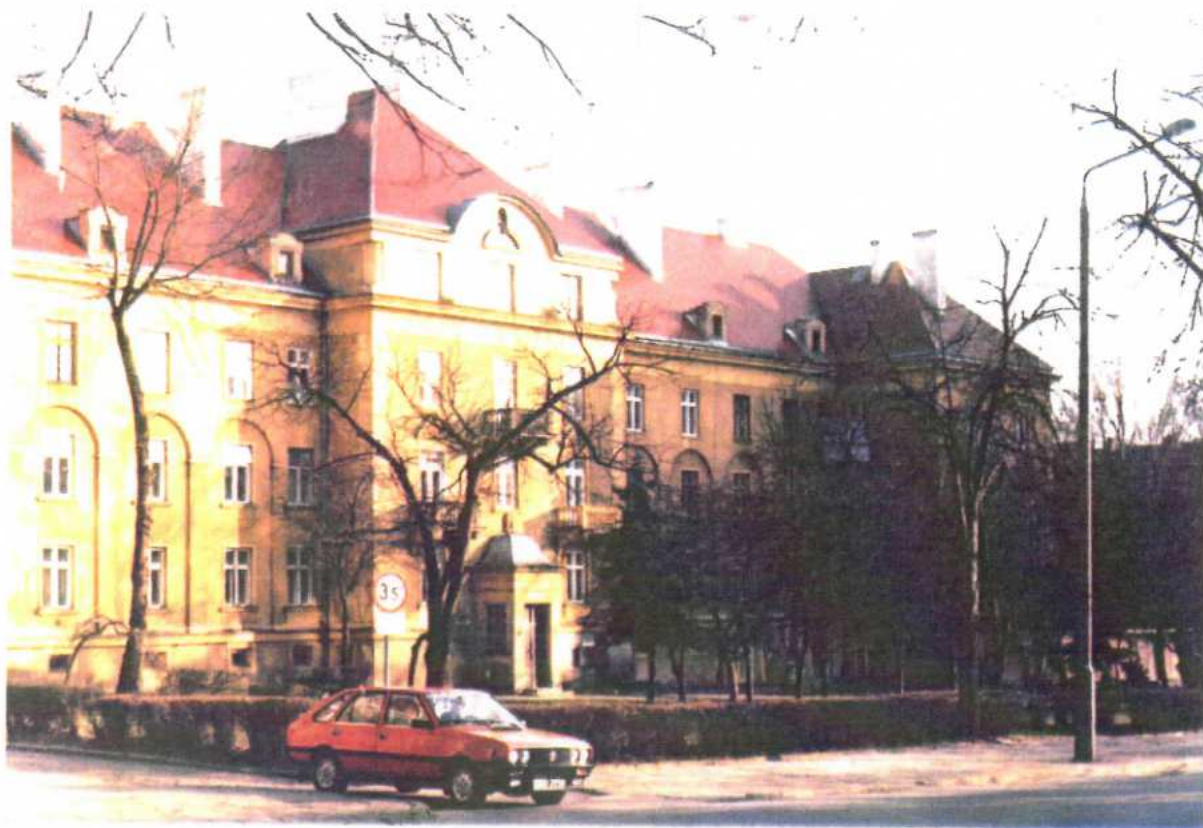
3. BUDYNEK PRZY UL. KOŚCIUSZKI 8
